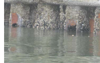
-6m岸壁の現況
