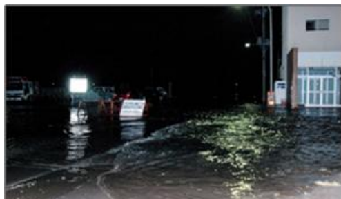
港内の浸水状況
