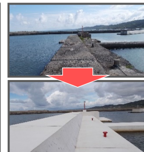
漁港施設の長寿命化対策
