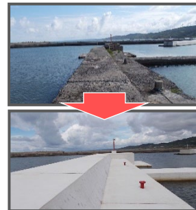
漁港施設の長寿命化対策
