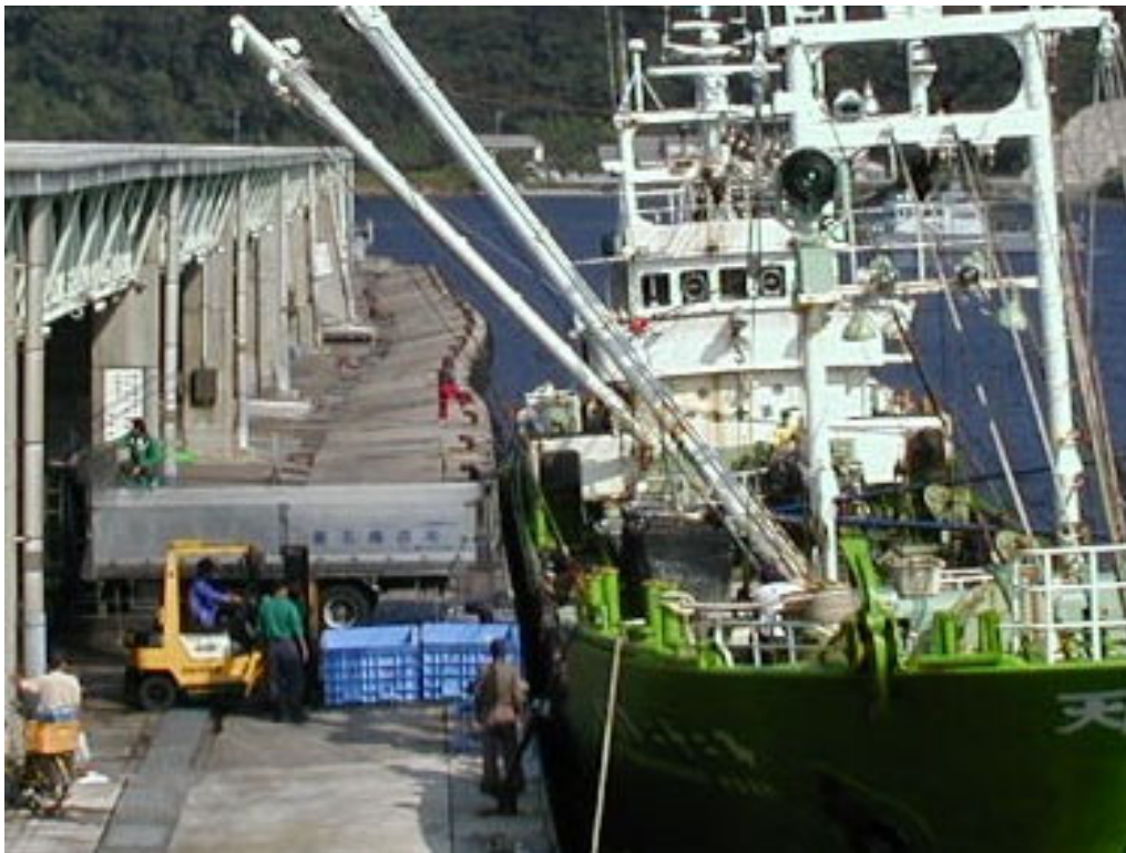
平成12年10月6日鳥取県西部地震 3号岸壁の先端が地震により半水没
