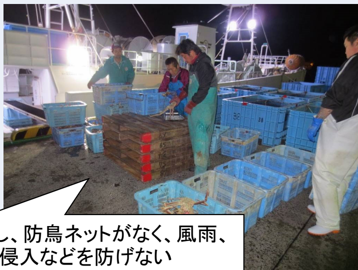
整備前(2号岸壁・上屋)
