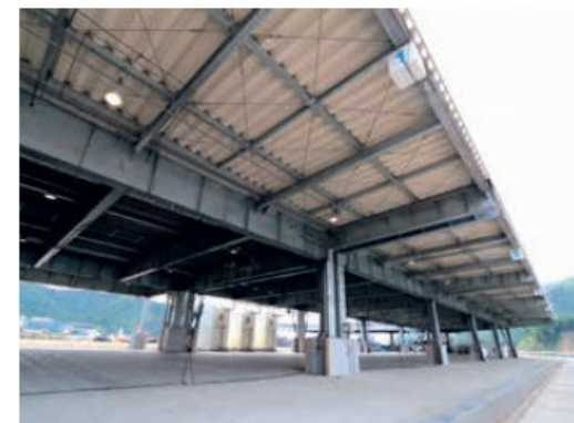
防鳥ネットを設置した荷さばき
