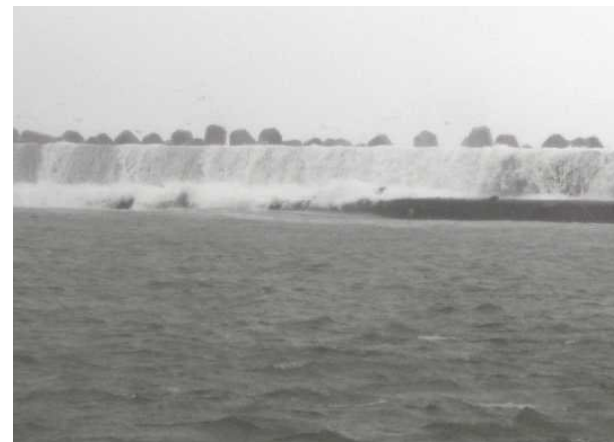
東防波堤からの越波状況
