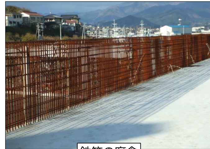
鉄筋の腐食
