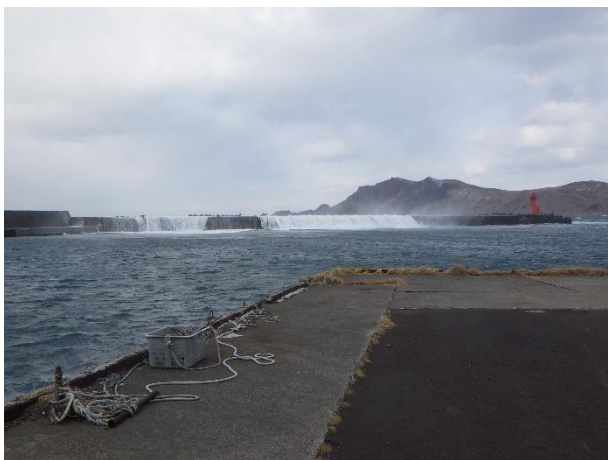
北防波堤からの越波(鉄府)
