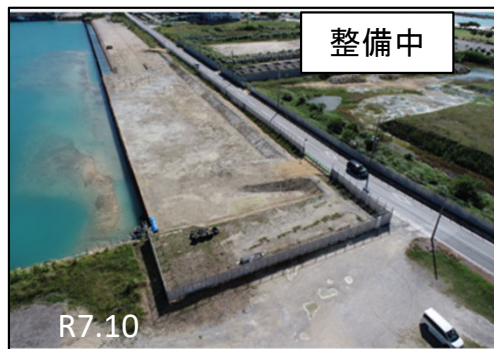
写真: -7.0m岸壁
