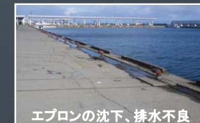
エプロンの沈下、排水不良
