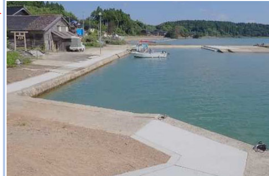
復旧が完了し、漁港内の全ての施設が利用可能となった。
