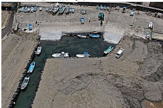
仮復旧事例：泊地の掘り込み、船揚場の前出しにより、陸揚げ作業が可能となった。
