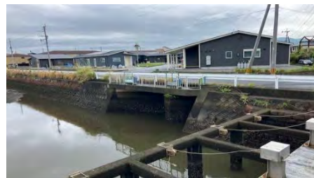
図15 ウナギ筒設置場所全景
