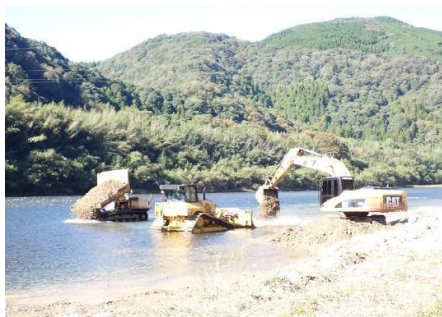
図 11.長良の瀬における造成の様子
