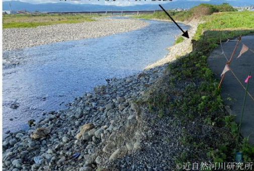
参考事例③：床止め上流の掘削土を下流の侵食河岸前面に投入（物部川_深淵床止め）
