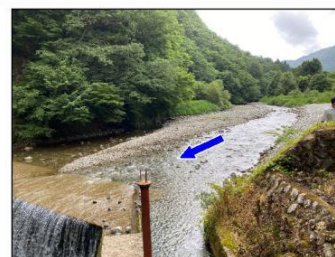
砂防ダム上流の堆砂状況
