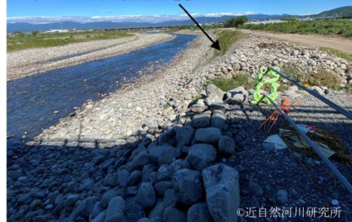
参考事例③：床止め上流の掘削土を下流の侵食河岸前面に投入（物部川_深淵床止め）
