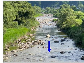
樹林化した砂州と低下した河床 (宮月橋から上流を望む)
