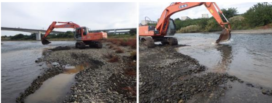
図6 河床耕耘と流路拡張により産卵場造成（寒川）
