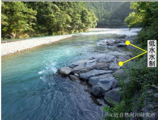
参考事例④：低水水制でみお筋蛇行と瀬・淵（河床の凹凸）を再生した事例（伊尾木川）
