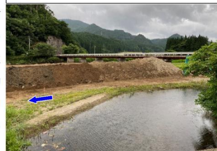
樺山発電所取水堰上流での河床掘削工事
