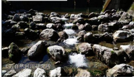
参考事例①：近自然魚道（成川川_砂防堰堤直下流）
