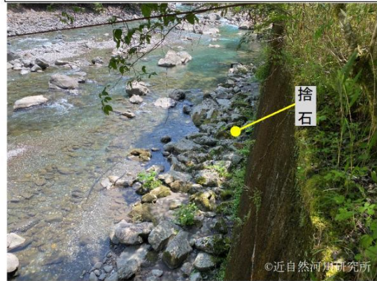
参考事例⑤：捨石でみお筋が護岸へ貼り付くのを抑えて、河床・水際の凹凸を創出した事例（物部川）
