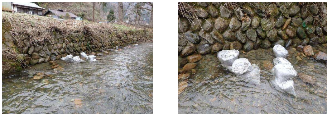
図2 土尻川に造成した小型構造物の様子（左：左岸遠景、右：土嚢で造成した構造物の様子）
