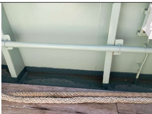
写真 5. 通路甲板補修箇所（FRP で補修している）
