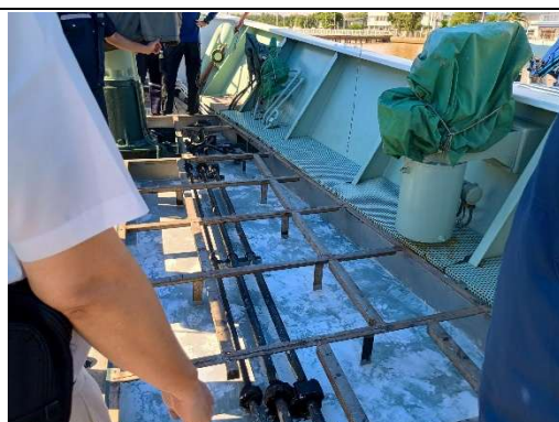
写真 6. 通路甲板修理中箇所
