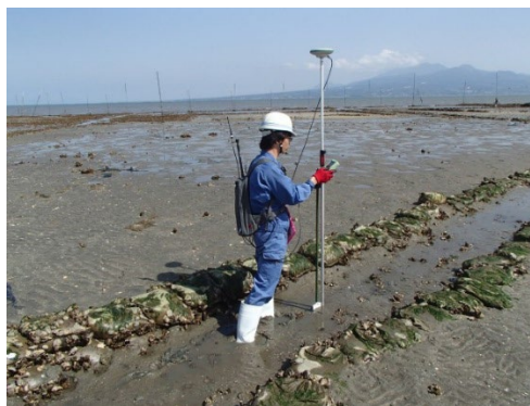
図 8 地形調査 (RTK-GPS) 作業状況
