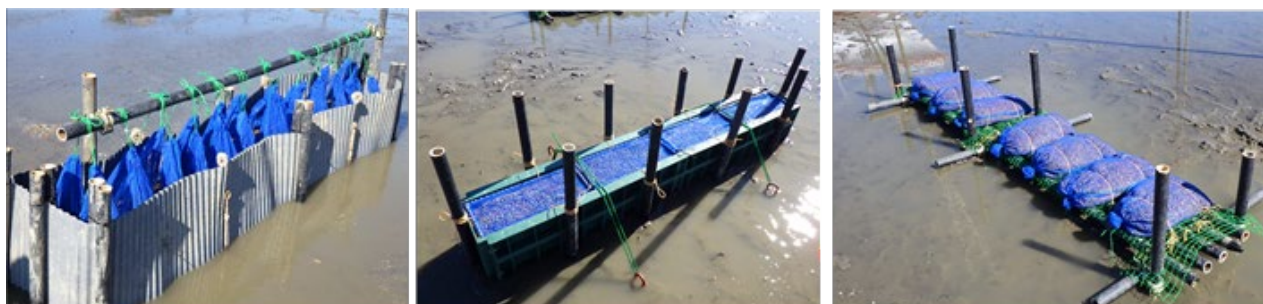
図 26 畔波(左)、プランター(中央)、及び網袋(右)の設置状況(豪雨前)
