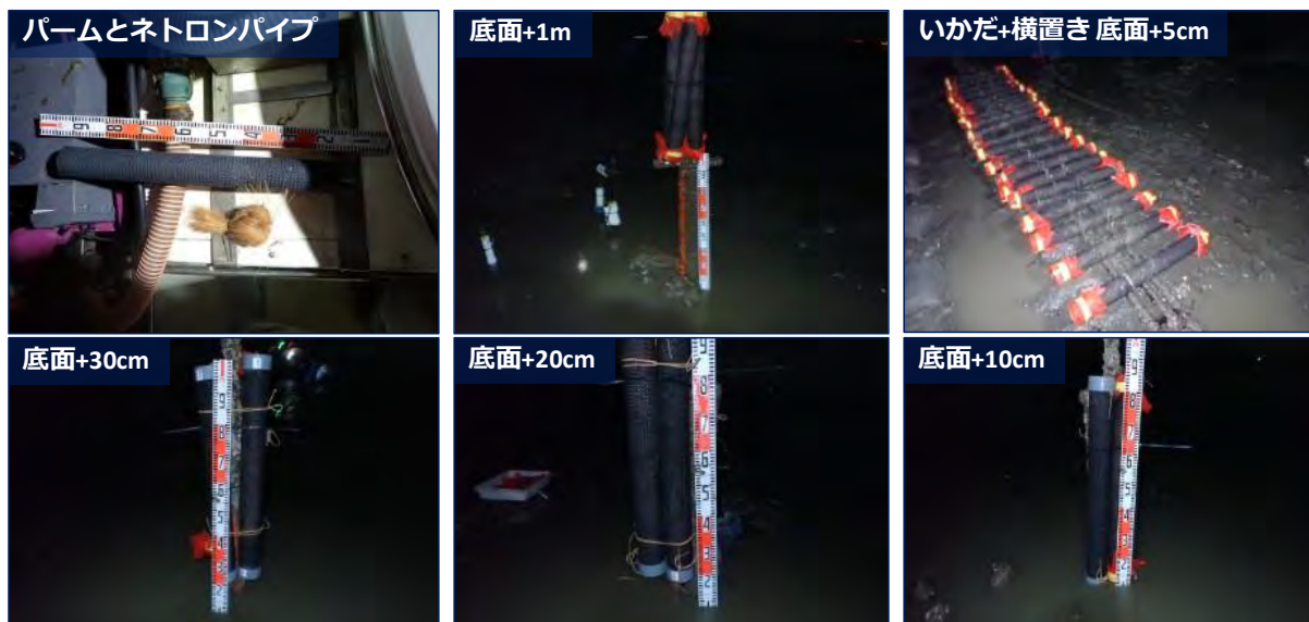
図 26 実験区に設置した「ネトロンパイプ+パーム」の様子(令和 6 年 12 月)
