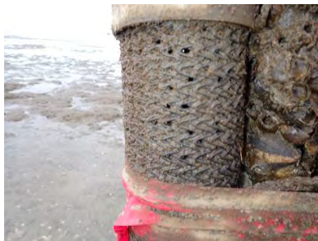
図29 令和7年5月時の「パーム入りネトロンパイプ」の様子
