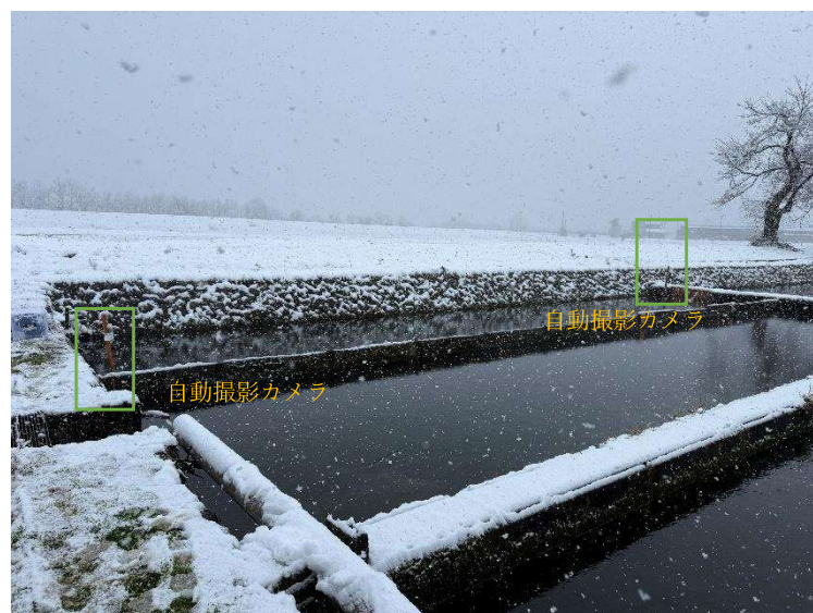
図2 現地の設置後の様子
