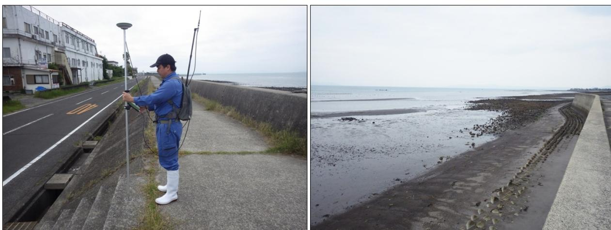
図7 地盤高測量実施状況（左）、猛島海岸全景および消波ブロック据付状況（右）
