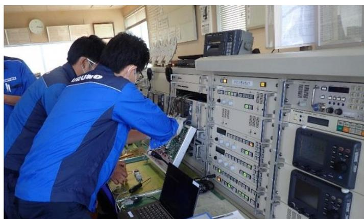
図 33-4 境港通信局で行われた無線機による潮流データ収集システム導入作業
