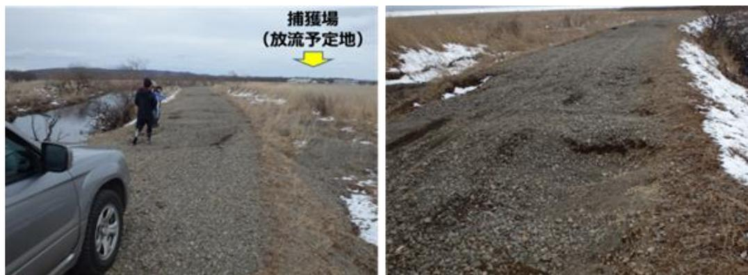
図 6. 輸送放流予定地へ繋がる砂利道. 凸凹大きく, 軟弱になった砂利道が 500mほど続く.
