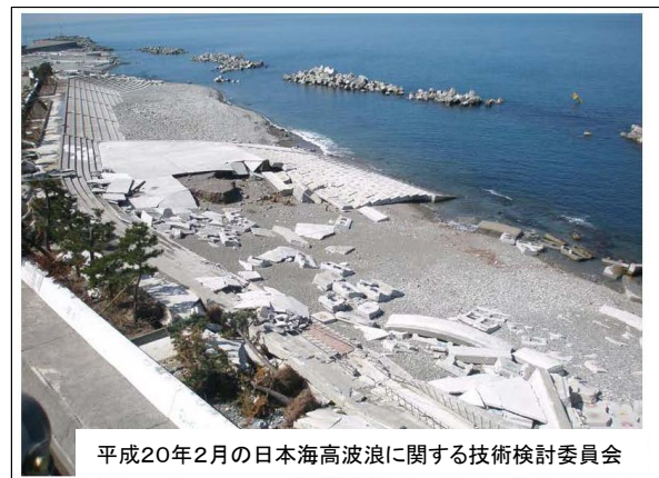
図 1-1 うねりに起因すると思われる被害事例 (左段：神奈川県西湘海岸、右段：富山県入善漁港海岸)
