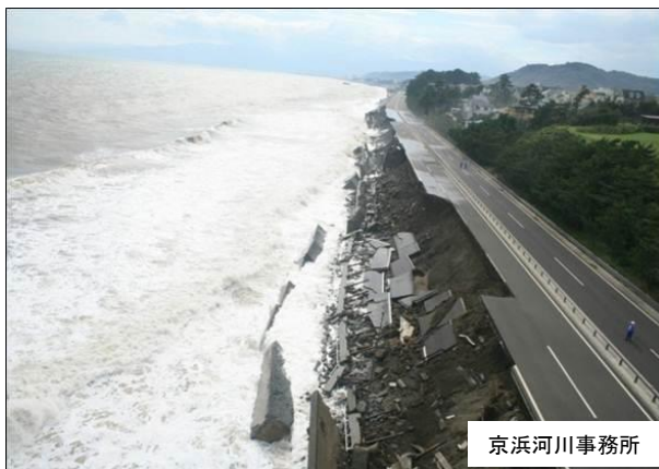
図 1-1 うねりに起因すると思われる被害事例 (左段：神奈川県西湘海岸、右段：富山県入善漁港海岸)
