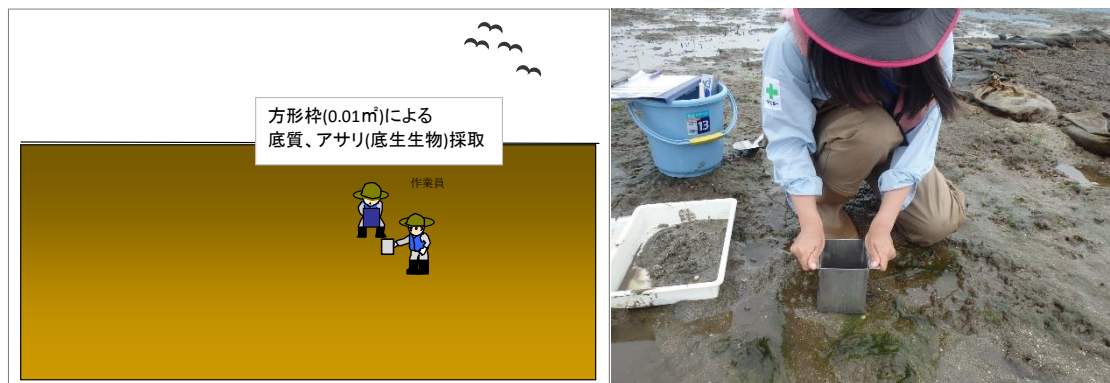
図 11 底質調査・生物調査 作業状況
