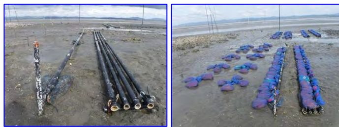
図22 泥土対策としての離底用コンポーズ(左)と基質入り網袋の設置状況(右)
