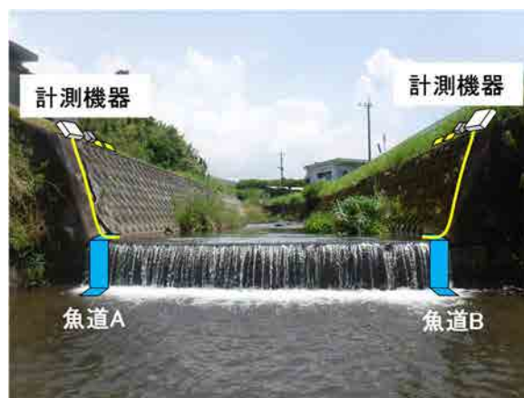
図3 簡易魚道及びアンテナ設置イメージ図
