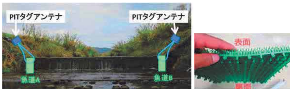
図2 アンテナによる比較調査イメージ（左）と芝マット（右）
