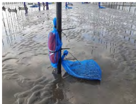
図29 現地盤に設置した碎石入り網袋 杭に括り付けてあるのはパーム採苗ネット(?)
