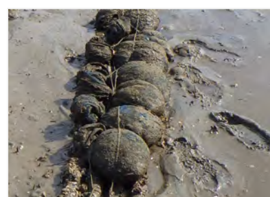
図58 泥土対策（離底型） 実験終了後の状況(8/14)
