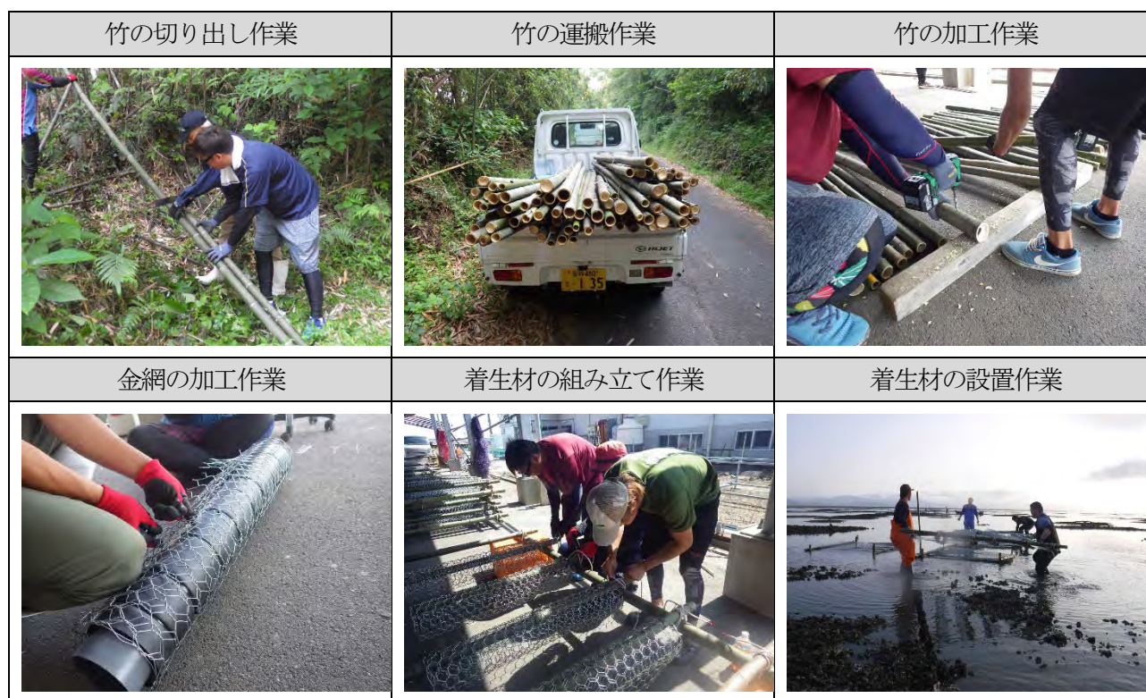
図43 漁業者との製作および設置状況
