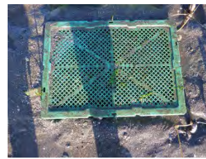
カゴの活用 変状なし
