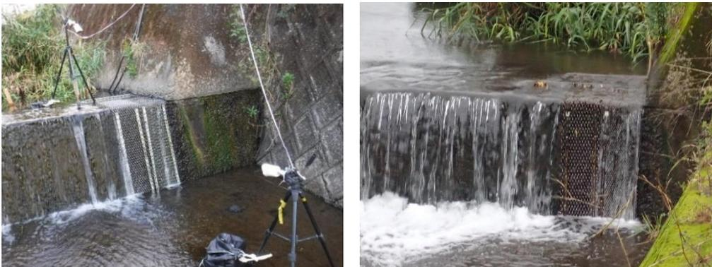
(図4) L型金網魚道 (左：設置時点、右：令和5年4月時点)
