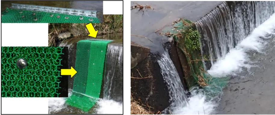
(図3) 補強型芝マット (左：設置時点、右：令和5年4月時点)
