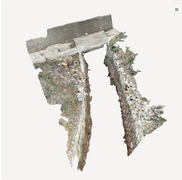
図9 アイパッドのLidar機能により撮影した島田島田尻地区地先湿地の3次元画像。写真は湿地からの排水路と海岸との間に存在する傍証邸の暗渠の開口部を撮影したもの。
