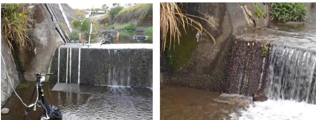
(図5) Z型金網魚道 (左：設置時点、右：令和5年4月時点)
