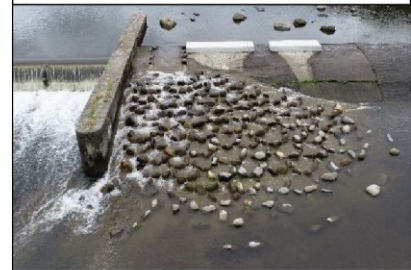
参考事例①：小わざ魚道(日野川_蚊屋堰)
