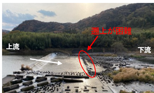
図 2 剣先堰堤の全体写真
