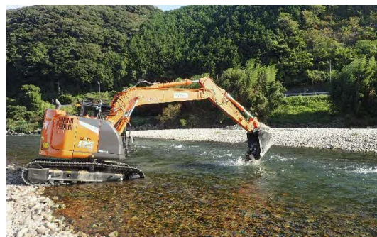
図 10 バックホーによる礫投入の様子
