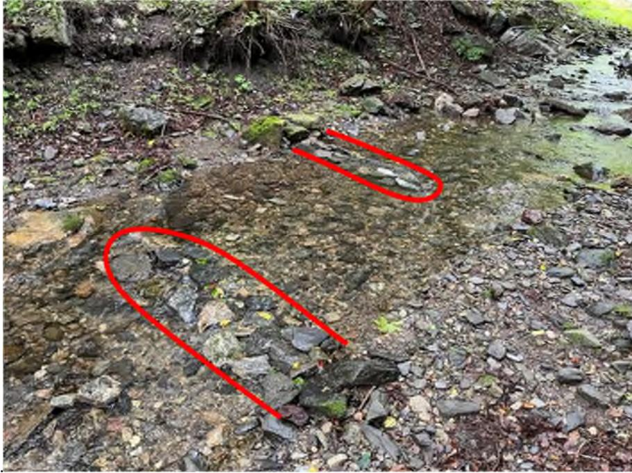
図 2. 住居附沢川介入区に設置した石組み
