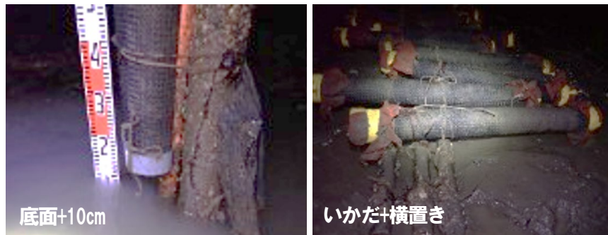
図26 実験区に設置したパーム入りネトロンパイプの様子（令和7年1月17日時点）
