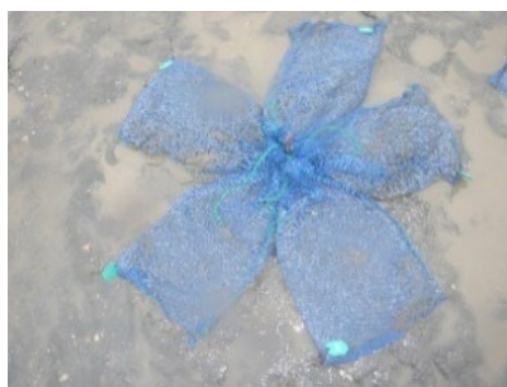
図 14 砕石入り網袋の設置状況
