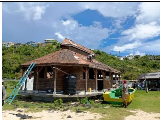
フレンドシップベイ水産複合施設（ハリケーン被害を受けた屋根を修理中）
