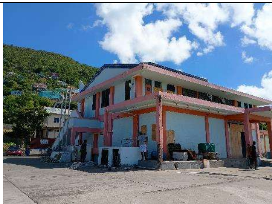
パジェットファーム水産複合施設（ハリケーン被害を受けた扉は修理済）
