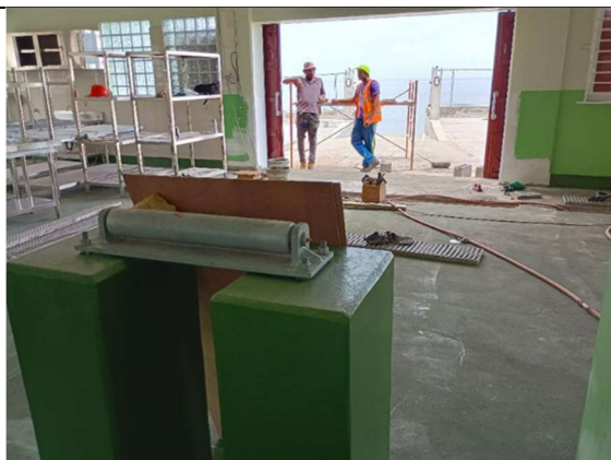
バルアリー漁業センター横で経済社会開発計画（無償資金協力）で建設途中の施設
