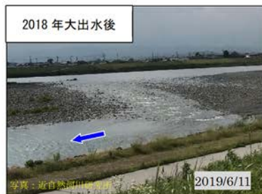
大出水で瀬の河床材料が「大きな玉石や巨石が少ない攪乱された土砂」になった
