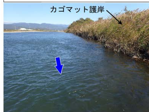
4. 8k 付近左岸の直線護岸(カゴマット)
