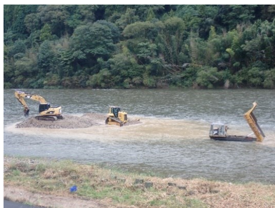
図 9 長良の瀬における造成作業の様子
