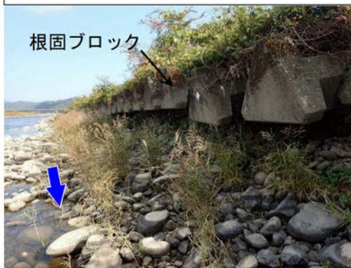
7. 4k 付近左岸の直線護岸(根固ブロック)
