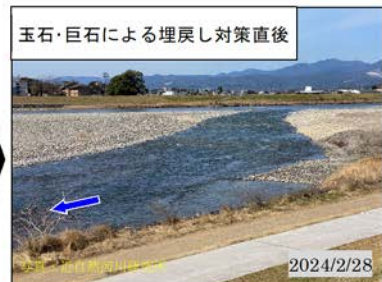
2024 年 2 月に洗掘された瀬を玉石・巨石で埋戻した。計画の埋戻量の 6 割程度を実施
