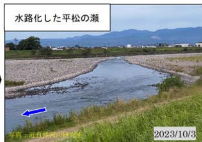
河床にアーマ層が十分に発達せず、下流から徐々に洗掘され水路状に掘れ込んだ
