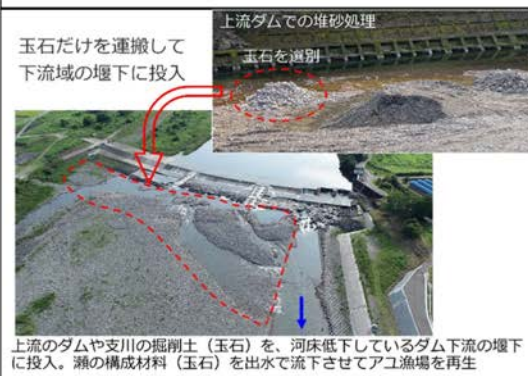
参考事例②：ダム湖等で発生した玉石を堰直下に投入（物部川、統合堰）
