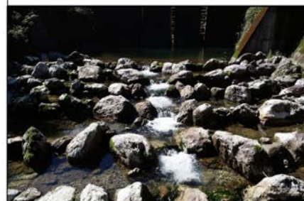
参考事例①：近自然魚道（成川川、砂防堰堤直下流）
