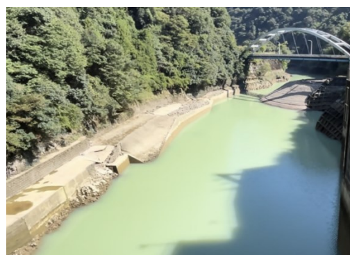
図4 宮ヶ瀬ダム直下の状況（10月2日時点）
