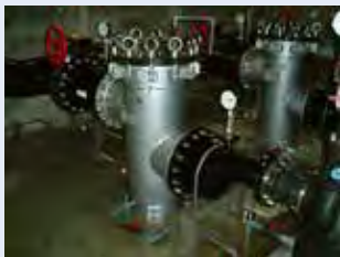
海洋深層水の活用（画像は取水施設）
