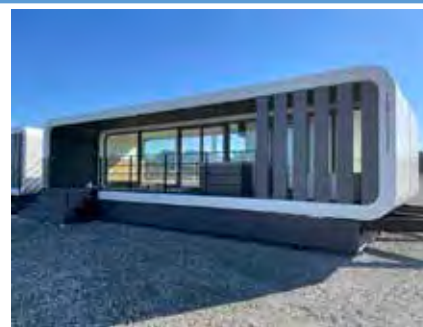
トレーラーハウス
