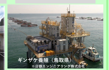
ギンザケ養殖（鳥取県） ※日敏エンジニアリング株式会社 大型浮沈式生簀や遠隔自動給餌システムによる省力化・生産性の向上
