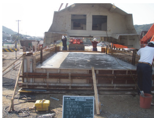
写真-5.15 FRP 漁船設置状況
