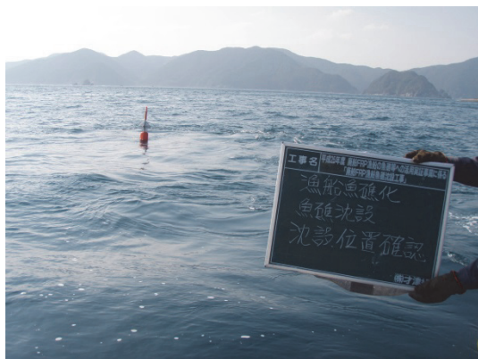
写真-5.18 目印ブイ設置状況
