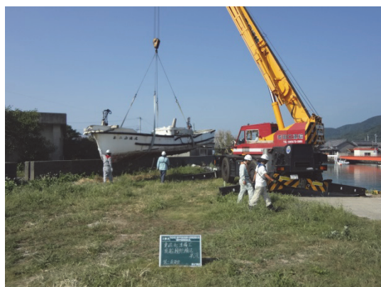
写真-5.1 FRP 漁船転置状況写真
