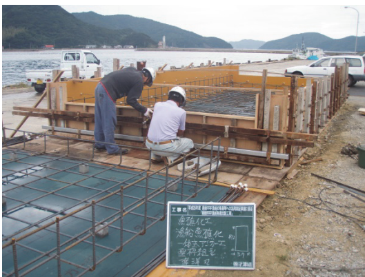
写真-5.12 型枠組立状況
