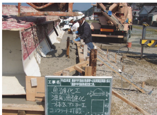
写真-5.16 FRP 漁船の埋め込み状況
