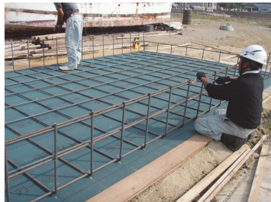
写真-5.11 鉄筋組立状況
