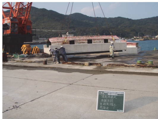
写真-5.19 FRP 沈船魚礁の積込状況
