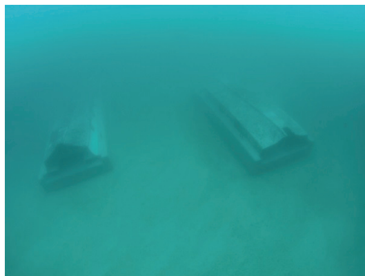
写真-5.21 沈設直後の FRP 沈船魚礁
