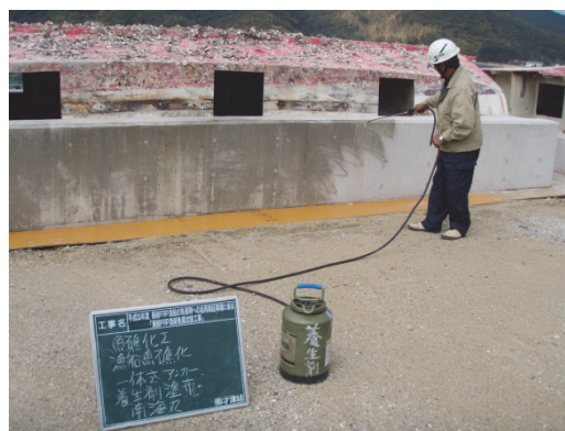
写真-5.17 コンクリート養生材の散布状況
