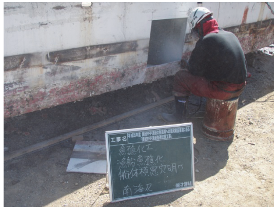
写真-5.9 開口部の切断状況
