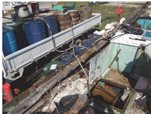
写真-5.23 油抜き取り状況
