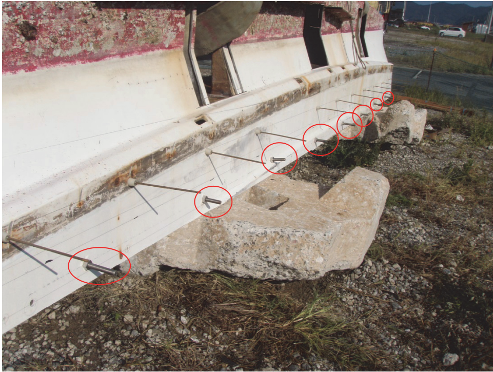
写真-5.8 アンカーボルト(SUS304、 \phi 18mm \times L200mm、8箇所/1側面 \times 2側面)
