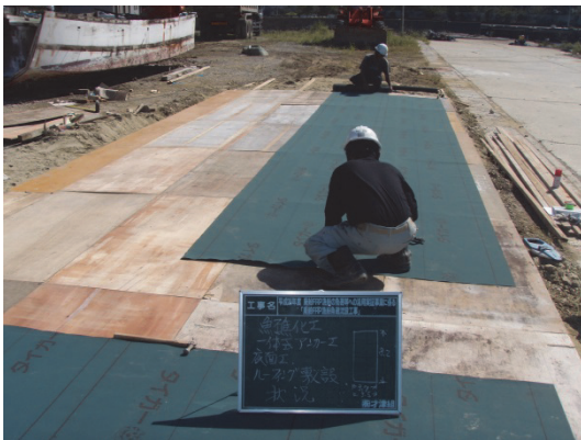
写真-5.10 アスファルトルーフィング敷設状況
