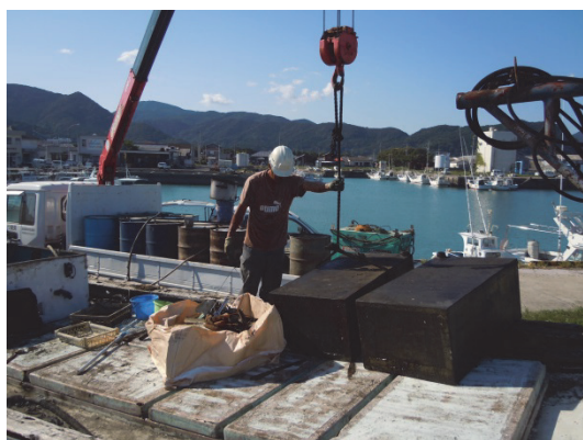
写真-5.24 不要資材等の搬出状況
