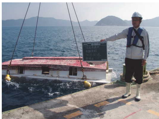
写真-5.20 沈設状況
