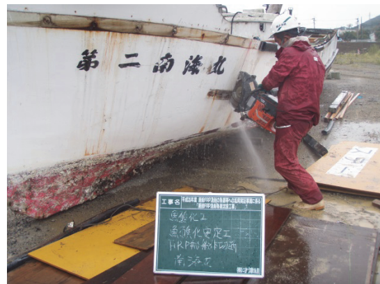
写真-5.7 切断状況(船首)
