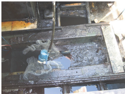
写真-5.22 油抜き取り状況
