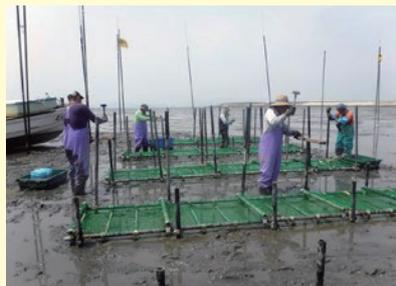
● 棚枠型離底器の枠組みの大きさは、船での搬送や作業性を考慮して、幅1m×長さ5m程度にしました
