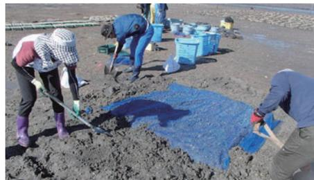
4. 上から等間隔(約1m)で杭を打ち、網を固定します。波当たりの強い場所では、杭を打つ間隔を短くします。
