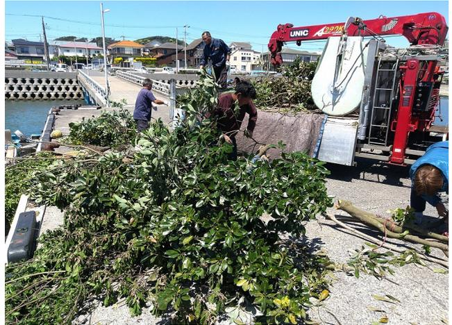
図2 伐採木を束ねて土嚢を付け産卵礁を作製
