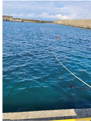
写真4 土のう移動後の幹縄 (2/5: 筒石)
