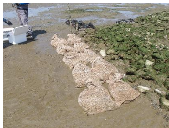
図 2 生分解性網袋の設置状況
