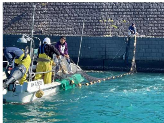
写真 1 食害防止網の設置作業
