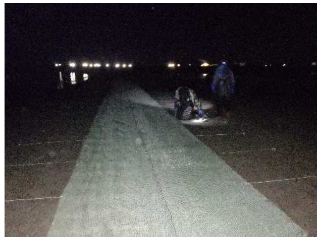
写真 2 設置した保護網
