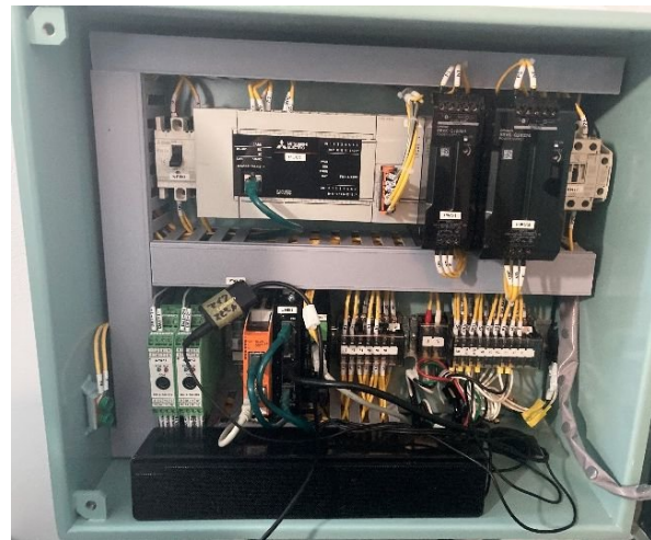
音声認識操作制御盤 (500×440×200mm, 約25kg)
