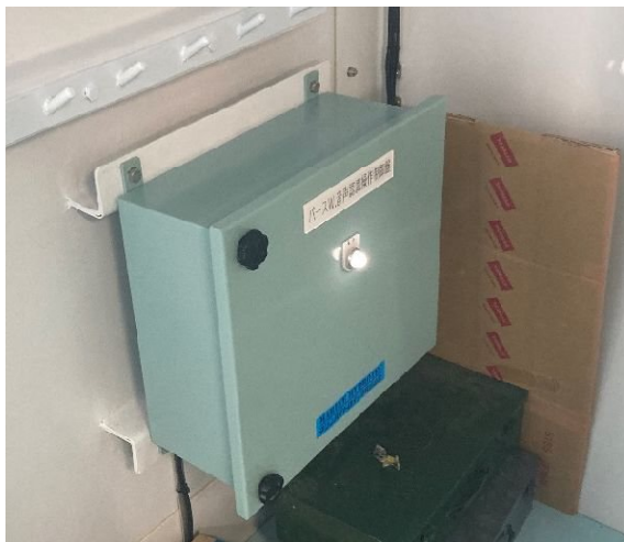
音声認識操作制御盤 (500×440×200mm, 約25kg)
