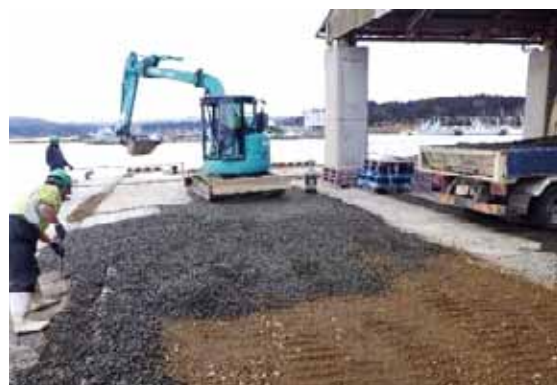
(復旧作業の状況)
