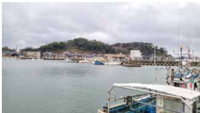
被災した輪島港の全景
