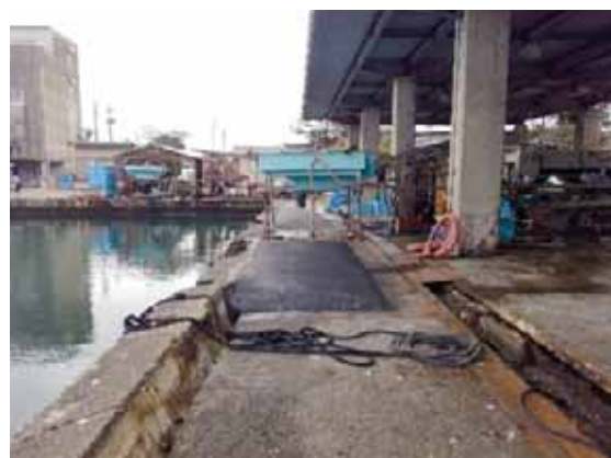
(復旧作業の状況)
