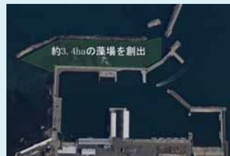
二重堤の整備後の状況
