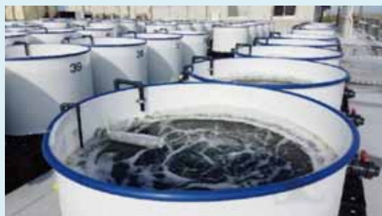
陸上養殖施設（屋外のタンク）
